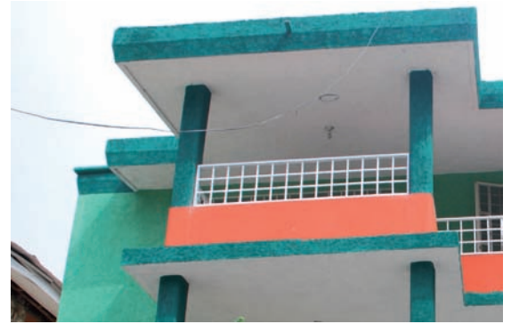
Le bâtiment du Centre, rue Cheriez
