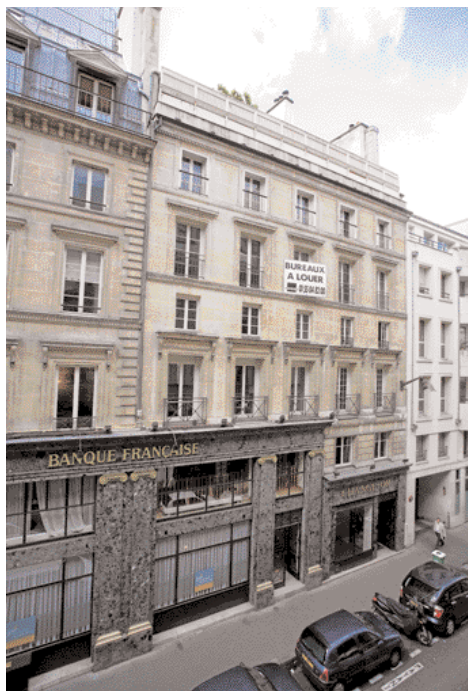
La façade du 47 rue Vivienne - PHOTO PIERRE PAYAN
